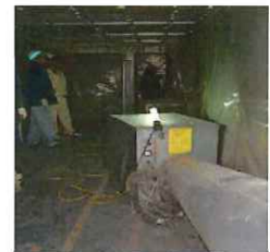
隔離養生区画内(除去作業前)
