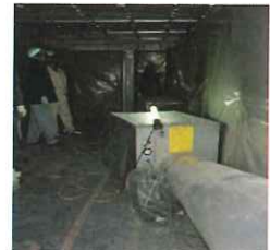
隔離養生区画内(除去作業前)
