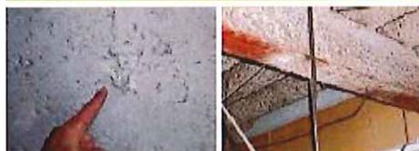
吹付け材等は長い間に強度低下や損傷が起こり、少しの外圧（打傷・擦過）で破損します。劣化や損傷している場合は、非常に飛散し易い状態になっています。
